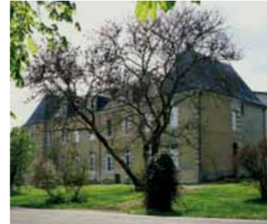
Façade est, ancien bâtiment des jésuites
